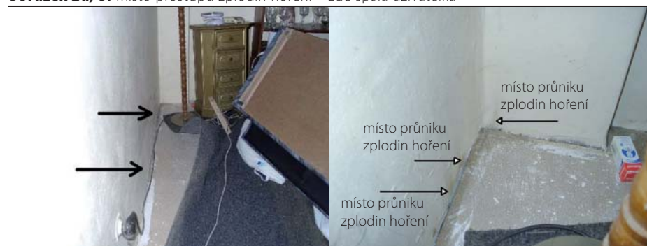
Obrázek 2a, b. Místo prostupu zplodin hoření – zde spala uživatelka
