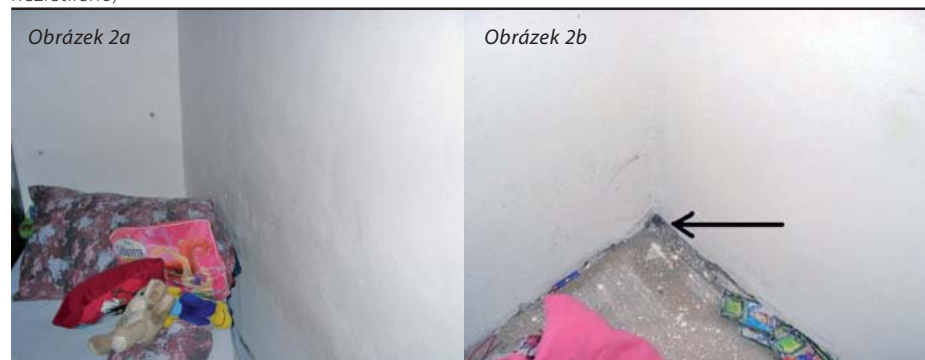
Obrázek 2a, b. Místo prostupu zplodin hoření – zde spala uživatelka
